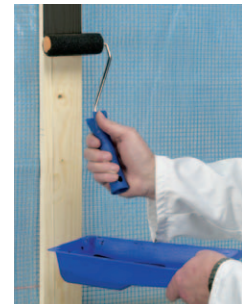
Voorbehandeling houten draagconstructie Primer SX Black
