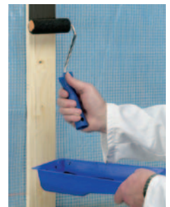
Voorbehandeling houten draagconstructie met Primer SX Black
