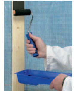
Voorbehandeling houten draagconstructie met Primer SX Black
