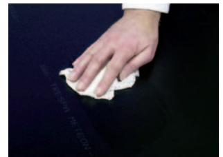
Voorbehandeling achterzijde steni met Easy Clean Wipes
