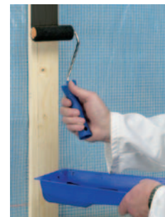
Voorbehandeling houten draagconstructie met Primer SX Black
