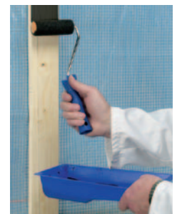
Voorbehandeling houten draagconstructie met Primer SX Black
