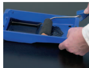
Voorbehandeling houten draagconstructie met Primer SX Black
