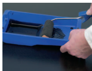
Voorbehandeling houten draagconstructie met Primer SX Black
