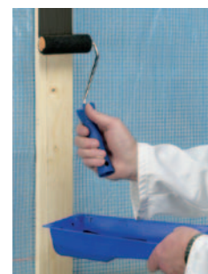
Voorbehandeling houten draagconstructie met Primer SX Black
