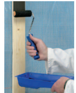
Voorbehandeling houten draagconstructie met Primer SX Black
